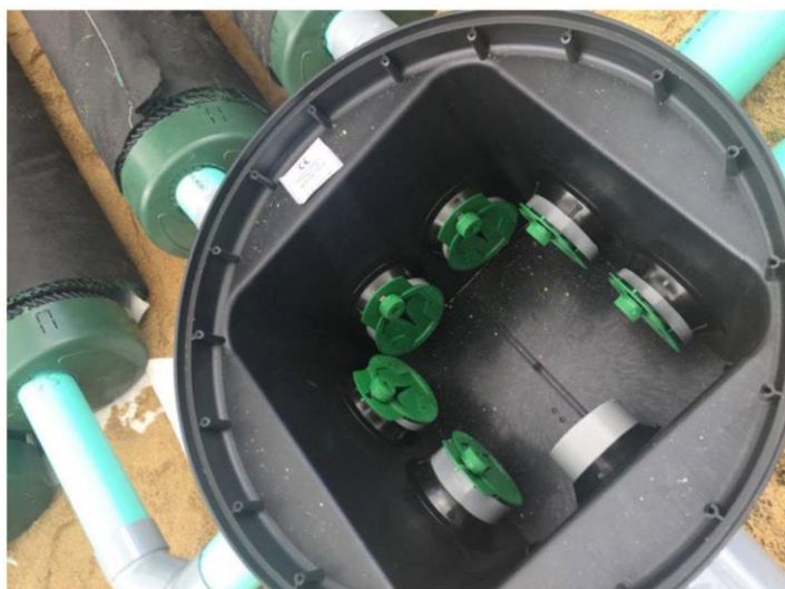
Figure 7. Représentation de la boîte de distribution D-Box 20
